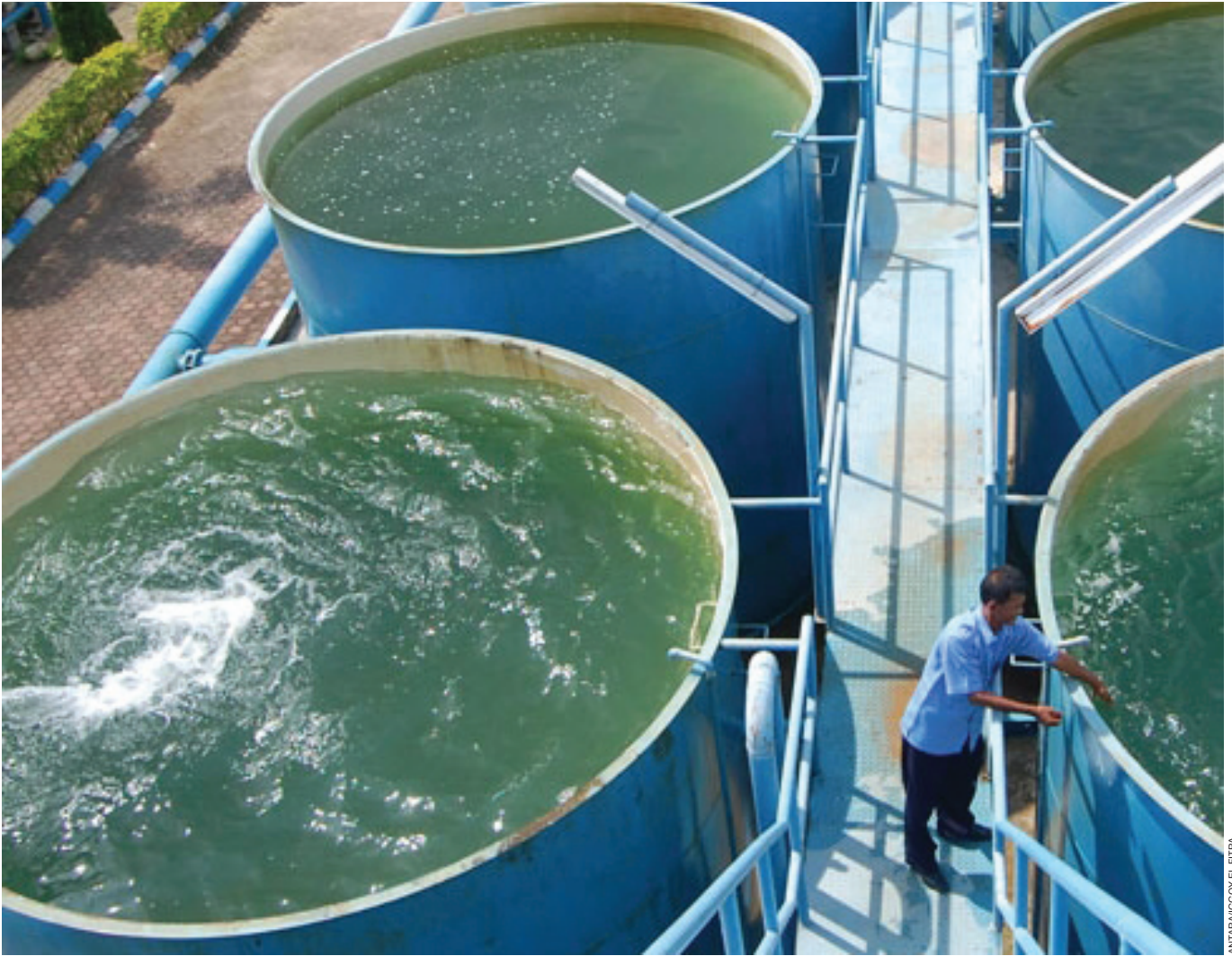
Petugas memeriksa delapan buah filter air di sebuah Perusahaan Daerah Air Minum (PDAM).
