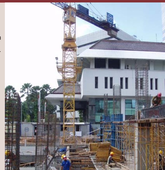
Proses pembangunan gedung baru MK.
