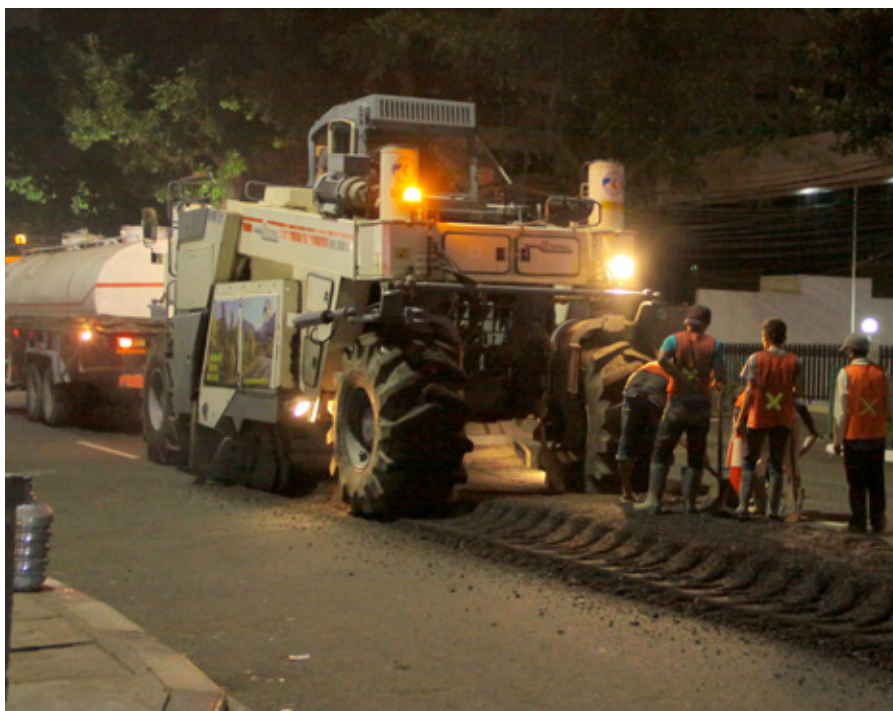
Proyek perbaikan jalan dengan menggunakan alat berat di Jl. Abdul Muis Jakarta Pusat.
