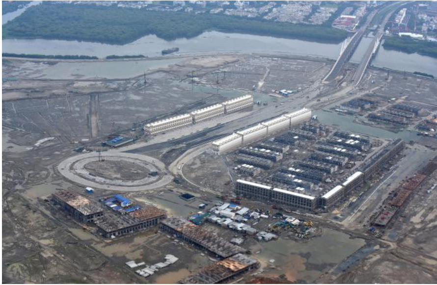
Foto udara suasana proyek pembangunan reklamasi Teluk Jakarta di Pantai Utara Jakarta, Minggu (28/2). ANTARA FOTO/Andika Wahyu/foc/16.
